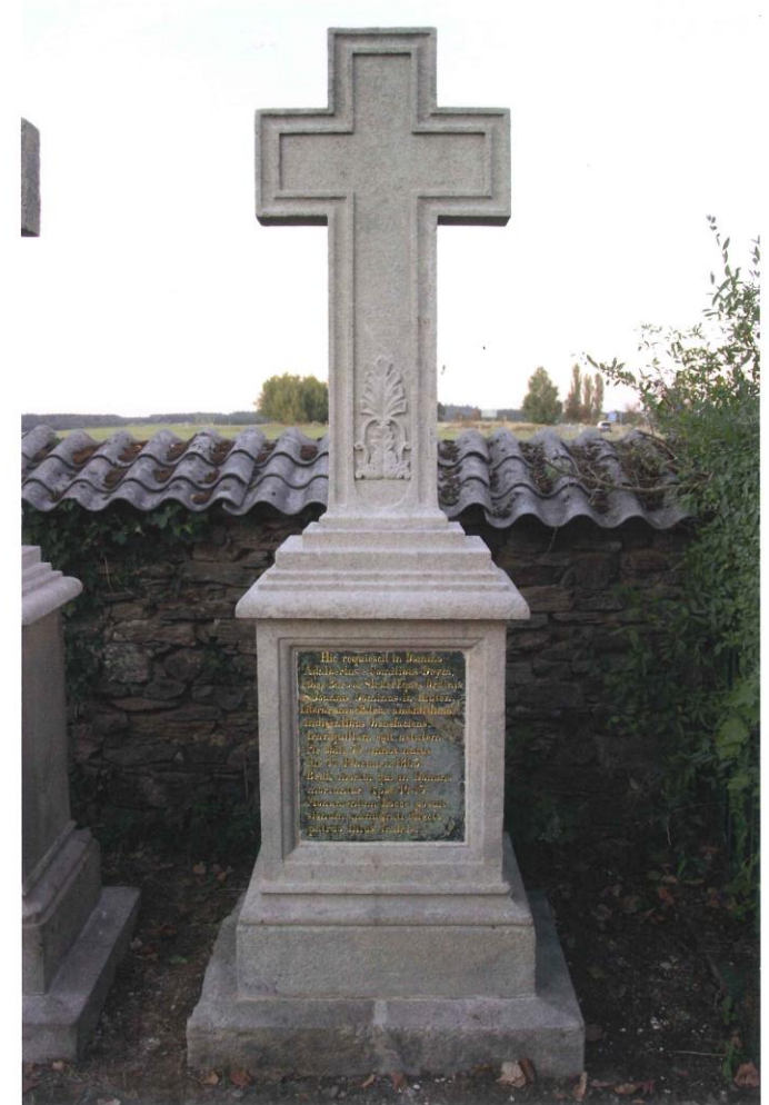
stav po restaurování
