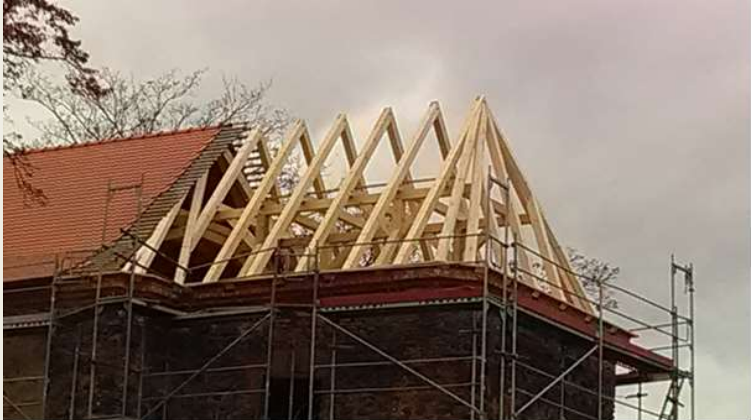
Obrázek 23 - výstavba nového krovu (2016)
