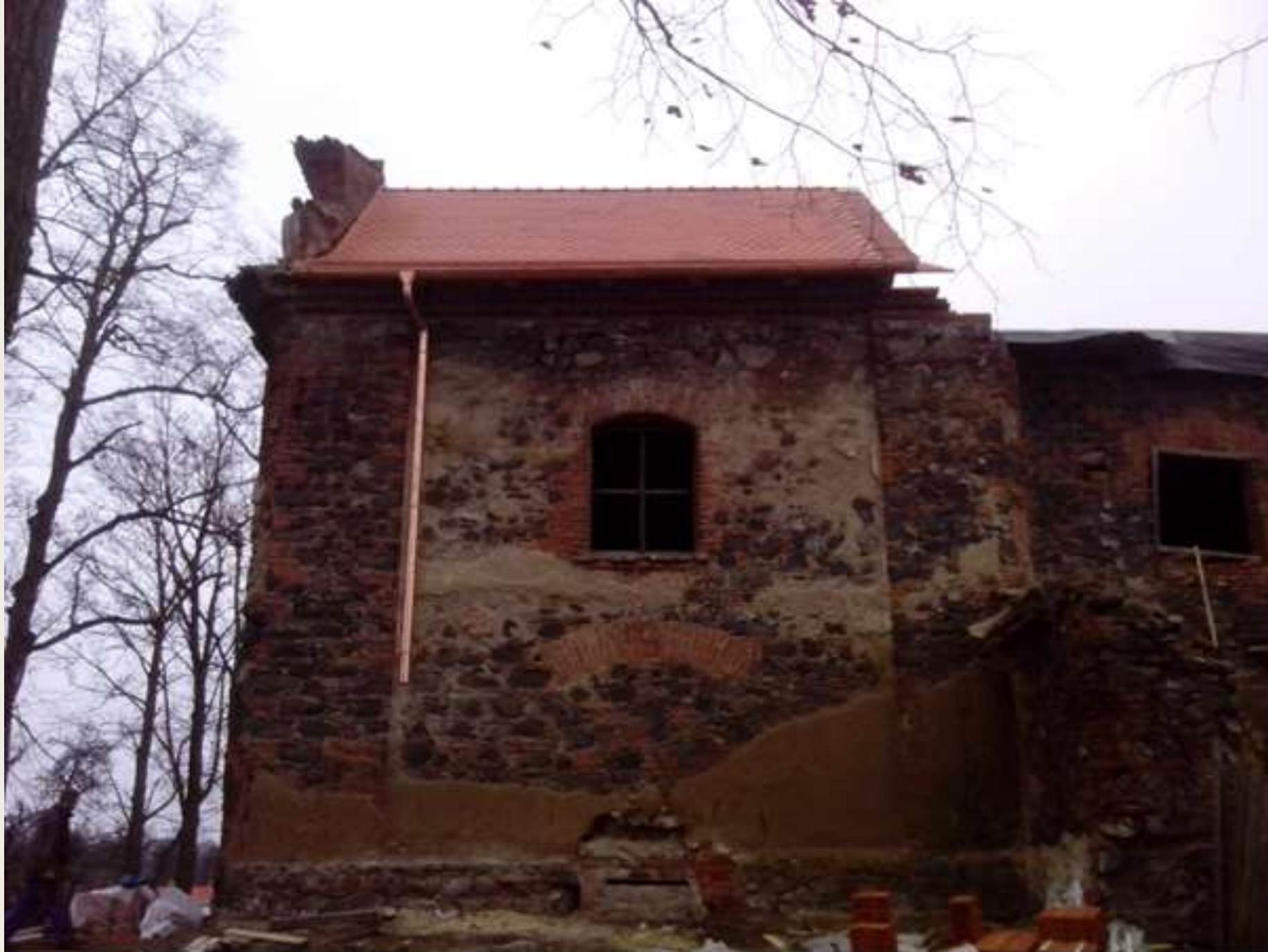
Obrázek 22 - výstavba nového krovu (2015)
