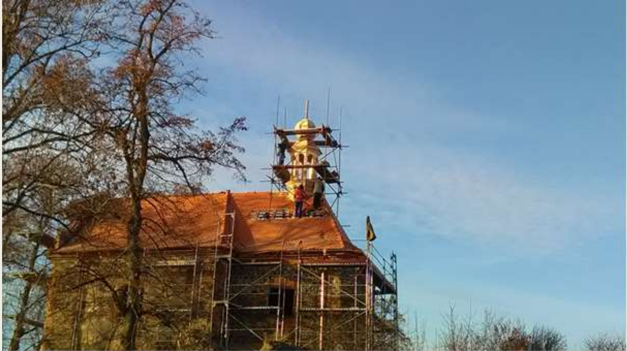
Obrázek 24 - výstavba nového krovu (2016)
