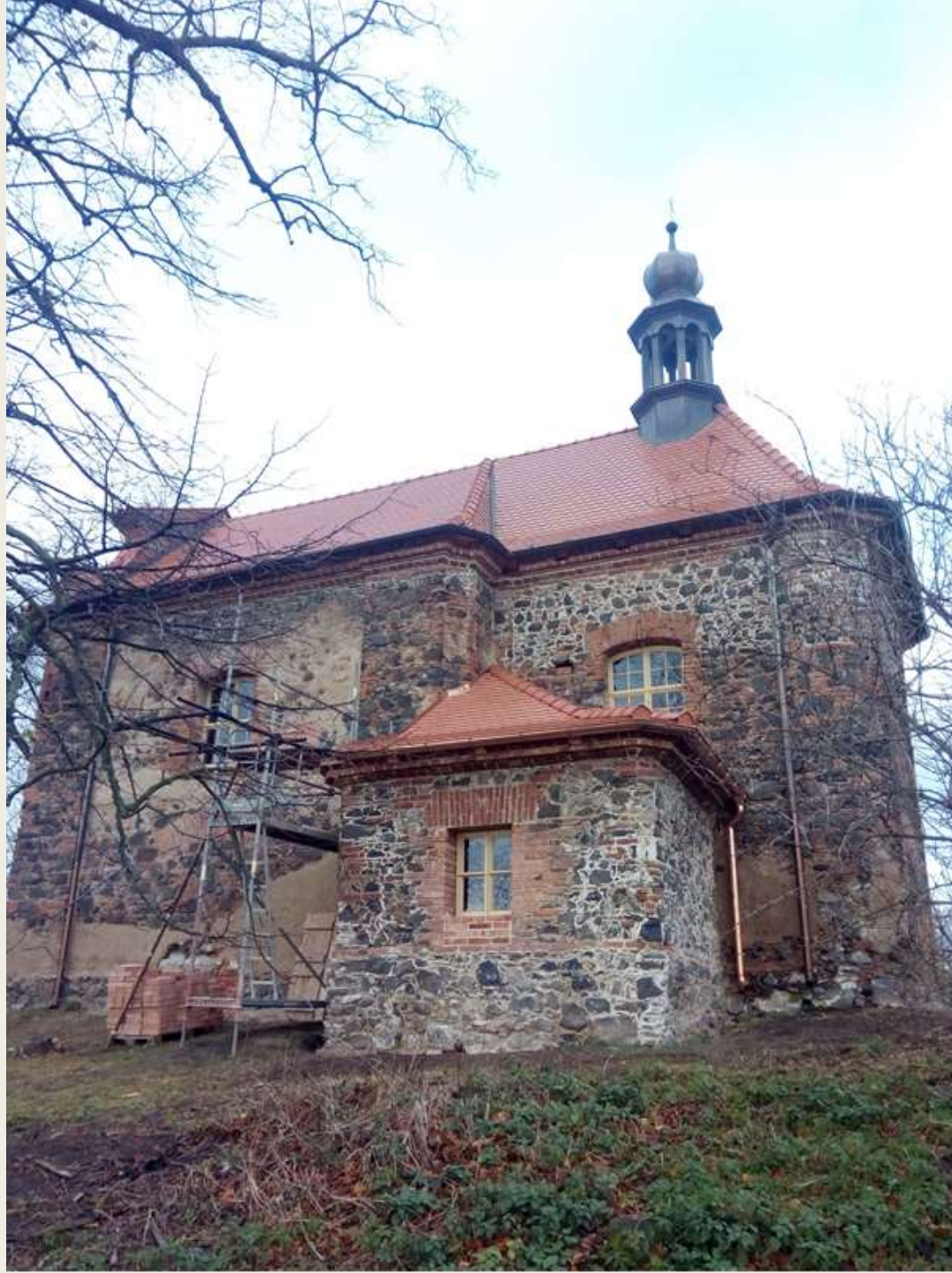
Obrázek 25 - dostavba a zastřešení sakristií (2017)
