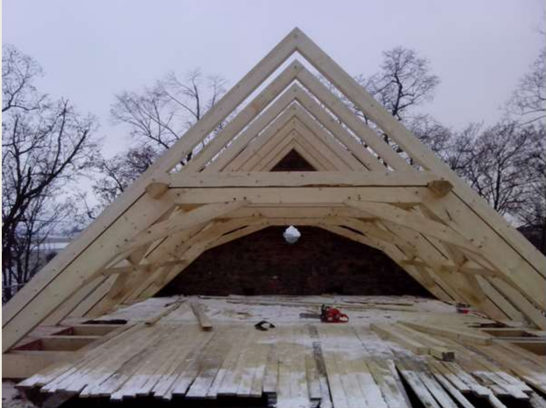
Obrázek 21 - výstavba nového krovu (2015)
