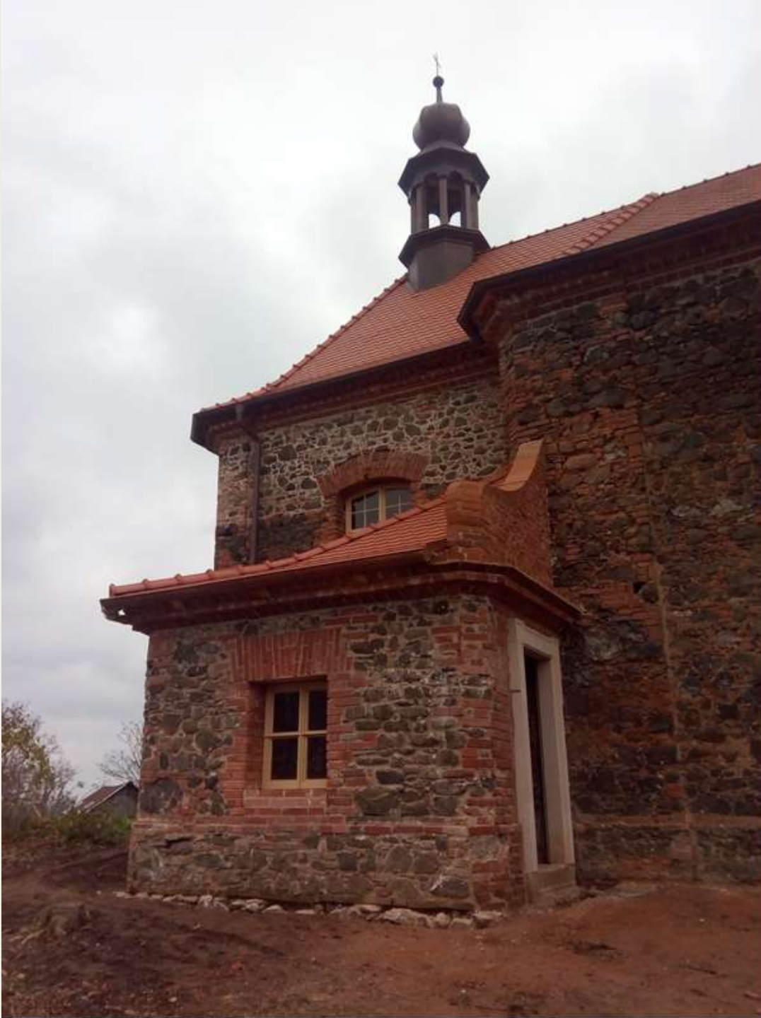
Obrázek 26 - dostavba a zastřešení sakristií (2017)
