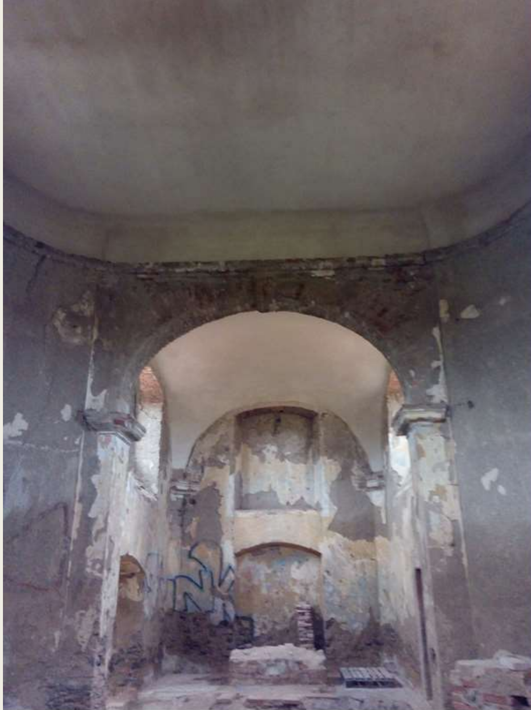
Obrázek 27 - opravy a doplnění stropů (2017)
