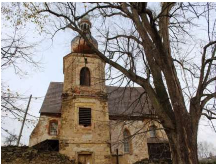
Současný stav - exteriér
